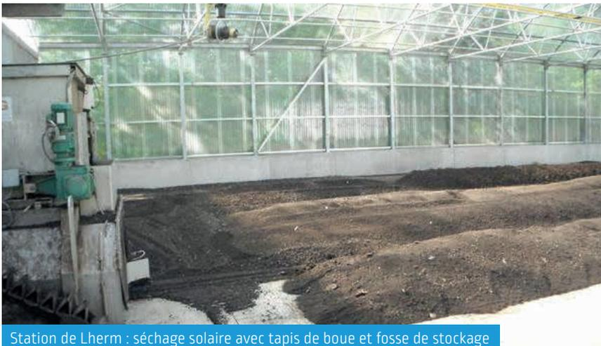
Station de Lherm : séchage solaire avec tapis de boue et fosse de stockage
