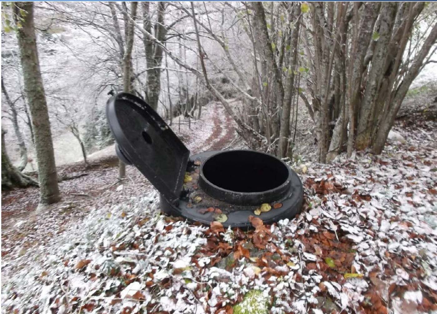
Vue extérieure du captage de la commune de Boutx
