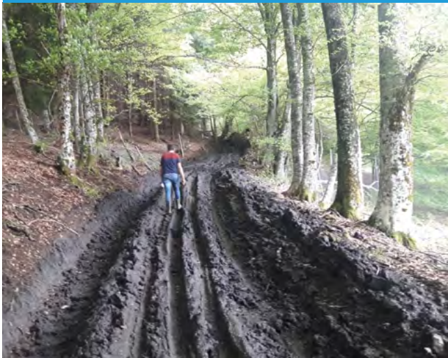
Portet d'Aspet - Captage Hontau : dégradation du chemin à proximité du captage
