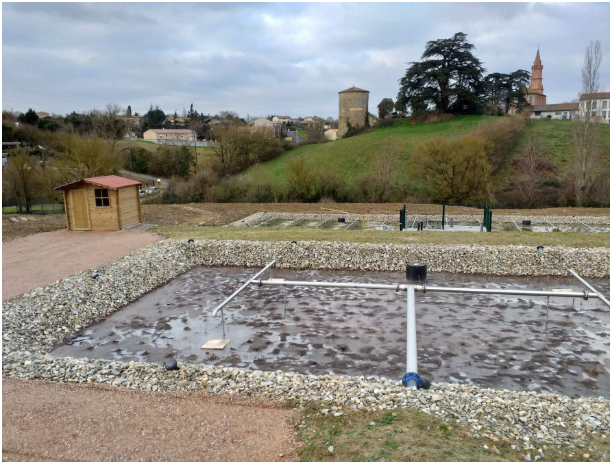
Station d'épuration de Lux
