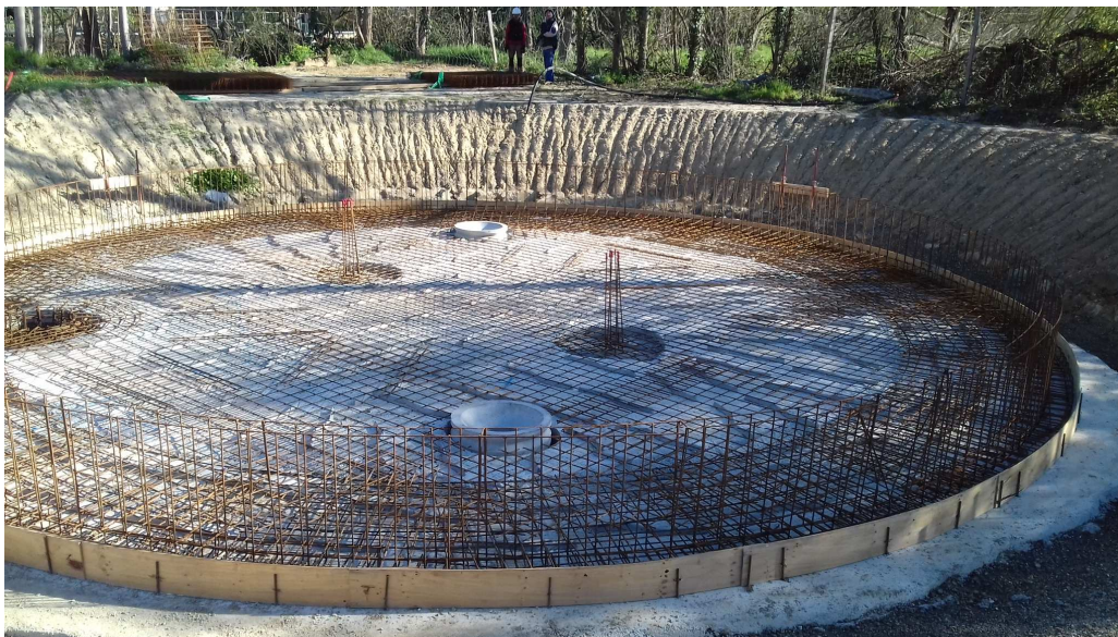
Travaux de construction de la station d'épuration de Launac
