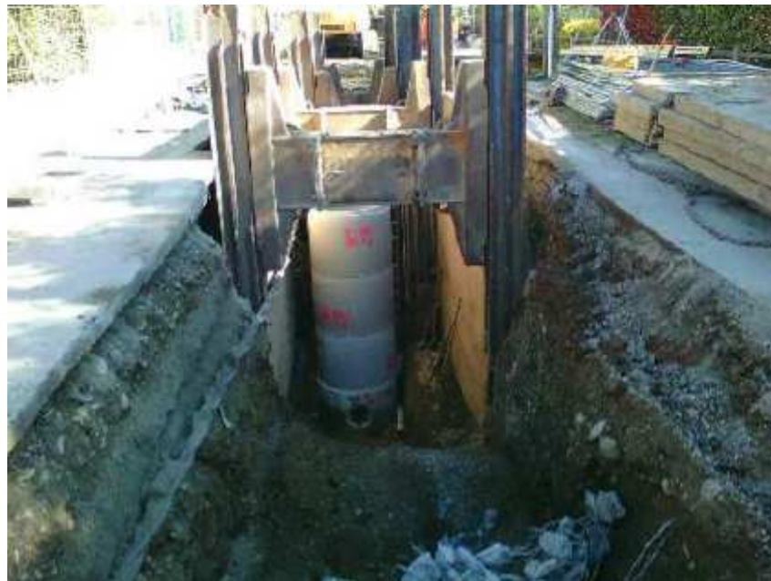
Travaux de création du réseau de transfert depuis l'ancienne vers la nouvelle station d'épuration de Carbonne
