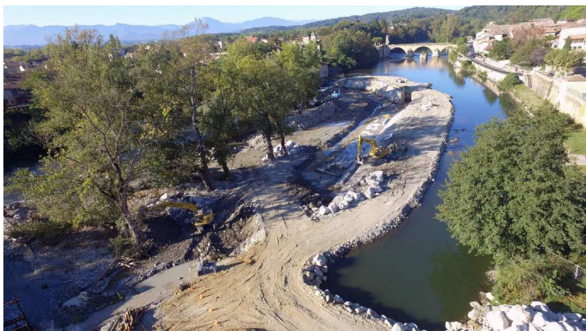
Travaux de consolidation de la chaussée de Saint-Martory
