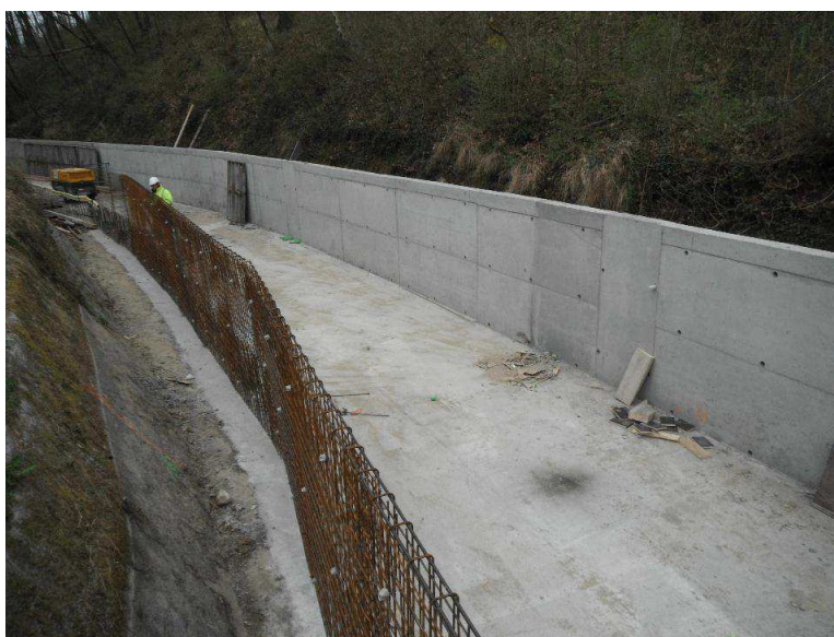
Travaux d'étanchéité du canal de Saint-Martory
