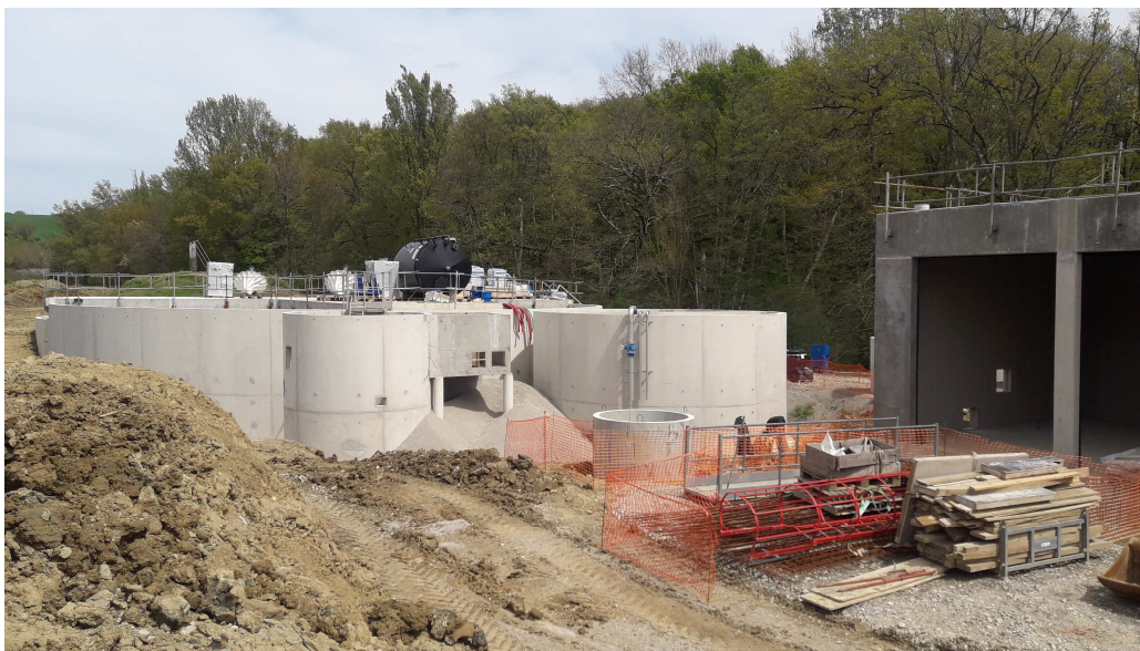
Travaux de construction de la station d'épuration de Montastruc la Conseillère
