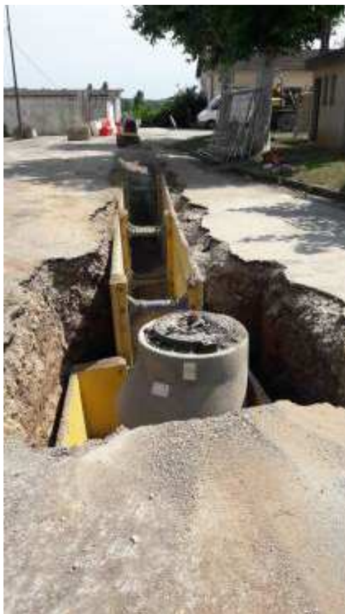
Travaux d'extension de réseaux d'assainissement sur la commune de Villematier
