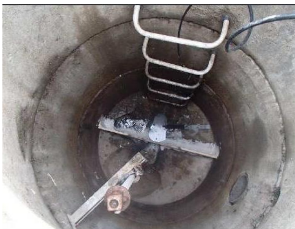
FIGURE 42 : MESURE DU DEBIT ENTRANT SUR LA STATION D'EPURATION
