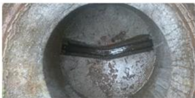
Regard de visite des eaux usées (4 jusqu'à la station).
