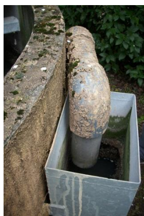
FIGURE 29 : DEPART DES EFFLUENTS PRETRAITES
