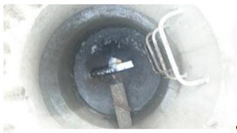
Regard de vue de l'arrivée des eaux usées en sortie des sanitaires de l'aire de repos.
