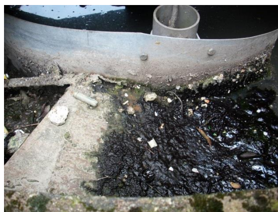
FIGURE 30 : RACLE DU DESSABLEUR-DEGRAISSEUR
