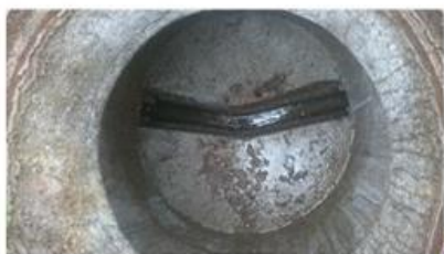
Regard de visite des eaux usées (4 jusqu'à la station)
