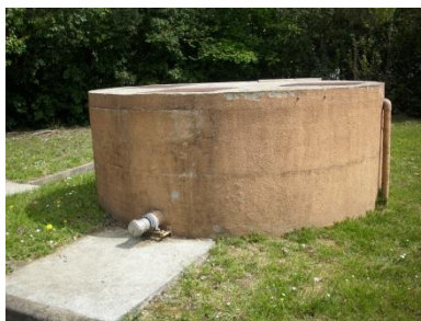
FIGURE 34 : SILO DE STOCKAGE DES BOUES
