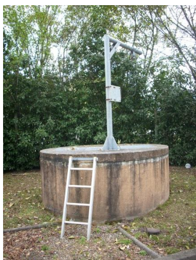
FIGURE 26 : POSTE DE RELEVAGE ENTREE DE STATION - VUE EXTERIEURE
