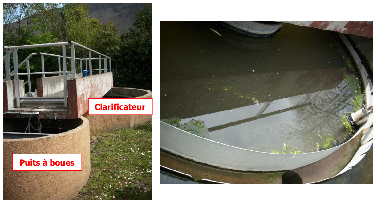
FIGURE 32 : CLARIFICATEUR
