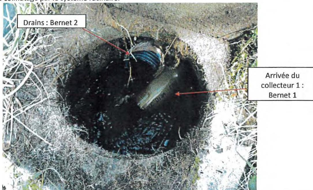
Figure 9 : Collecteur 2 : arrivés de Bernet 2 (drain cannelé bleu) et du collecteur 1 (tuyau pvc 100)
