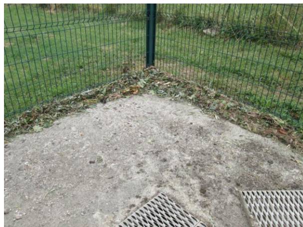
Signes d'écoulement pluviaux
