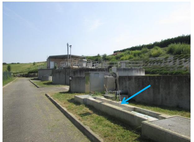
Vue générale – Canal Venturi
