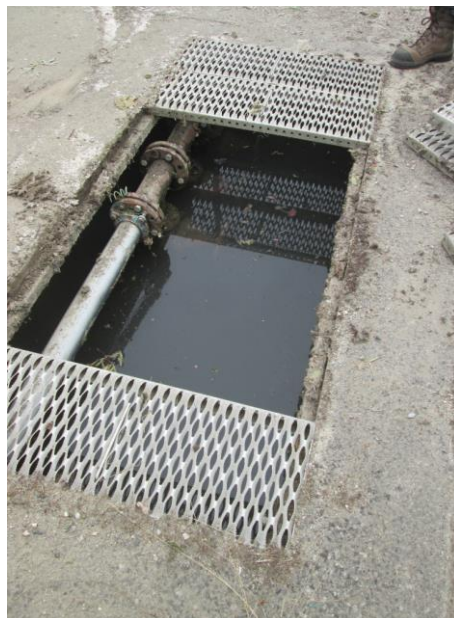
Chambre des vannes noyée
