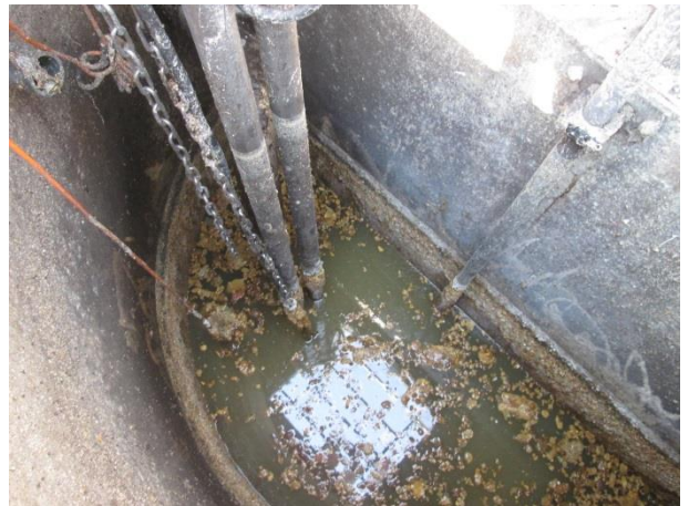
Intérieur du poste de refoulement constitué de 2 cuivons séparés
