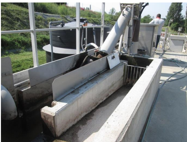
Dégrilleur à vis
