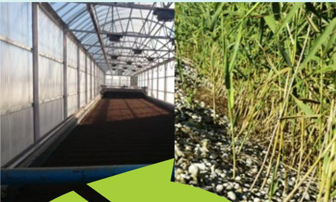
Réseau31 a privilégié l'innovation écologique et technologique en optant pour le séchage solaire sous serre et la création d'une zone d'infiltration végétalisée des eaux traitées
