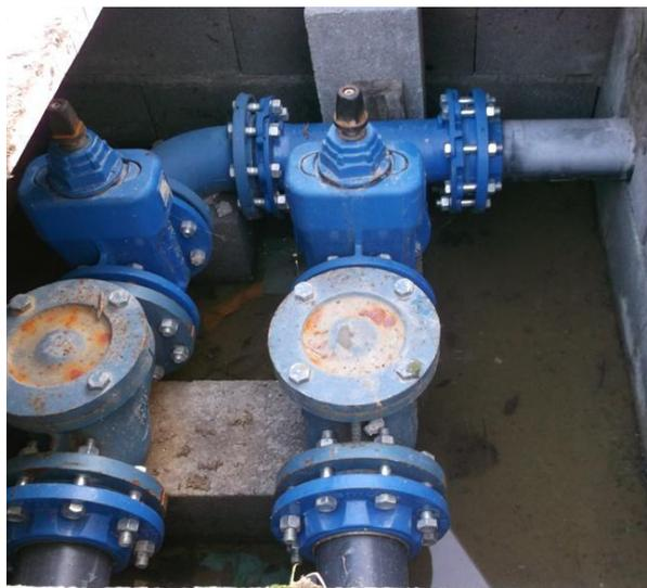
**PHOTOGRAPHIE 3 : CLAPETS A BOULES ET VANNES**
