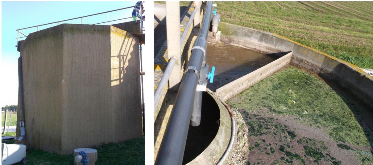
PHOTOGRAPHIE 5 : DÉCANTEUR-DIGESTEUR
