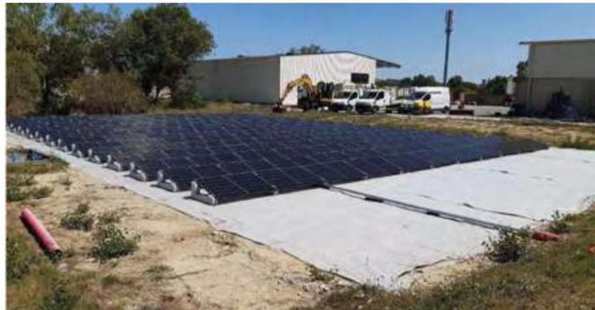
Travaux de pose d'une centrale photovoltaïque pour les besoins de la STEP
