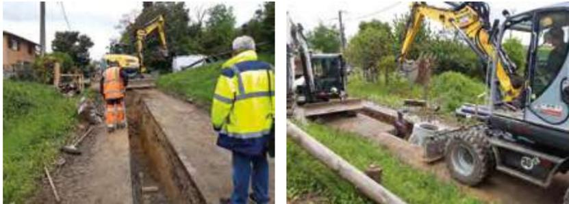
Création d'un réseau de transfert de 240 ml, d'un réseau de collecte d'eaux usées de 450 ml et de 20 branchements
