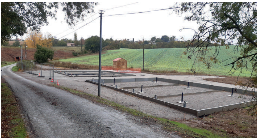
Construction de la station d'épuration de Sainte-Livrade
