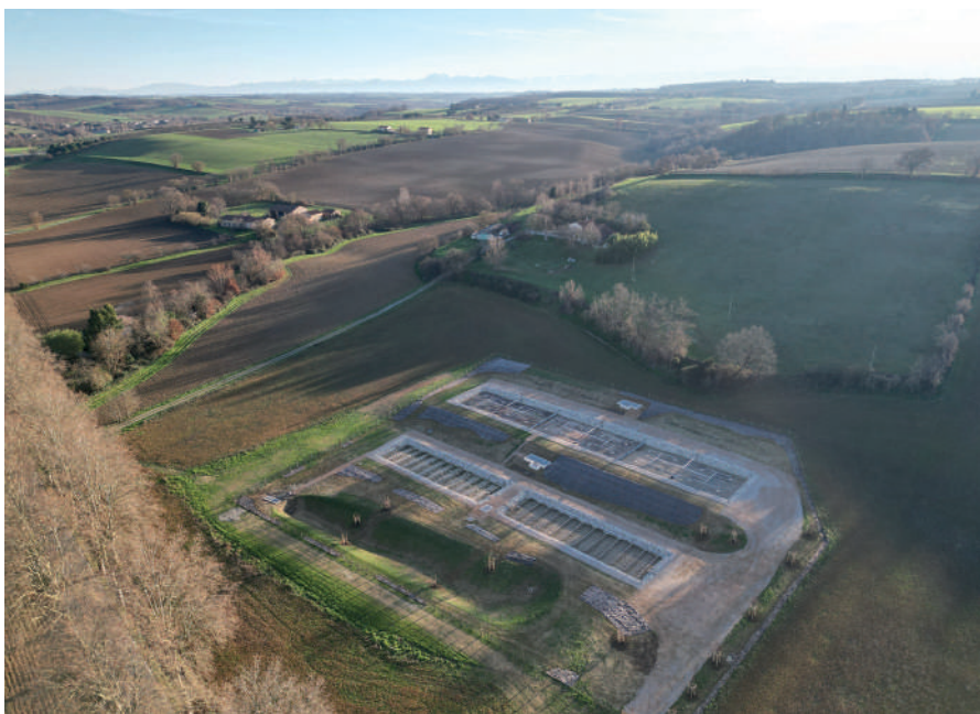
Construction de la station d'épuration de Montesquieu-Lauragais
