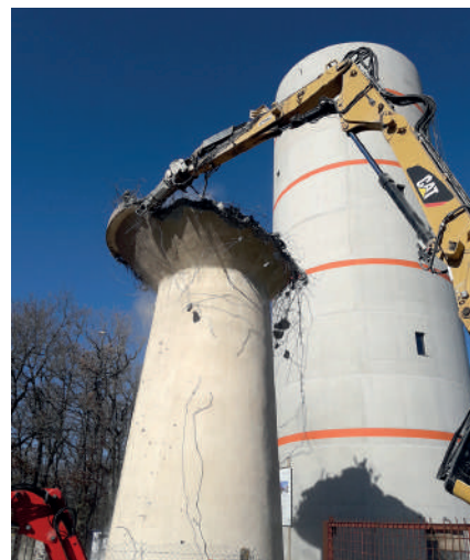
Construction du nouveau réservoir de Préserville
