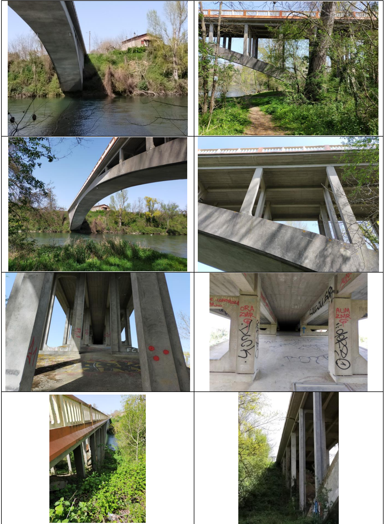
Figure 20 : Photographies du pont de Saint-Julien
