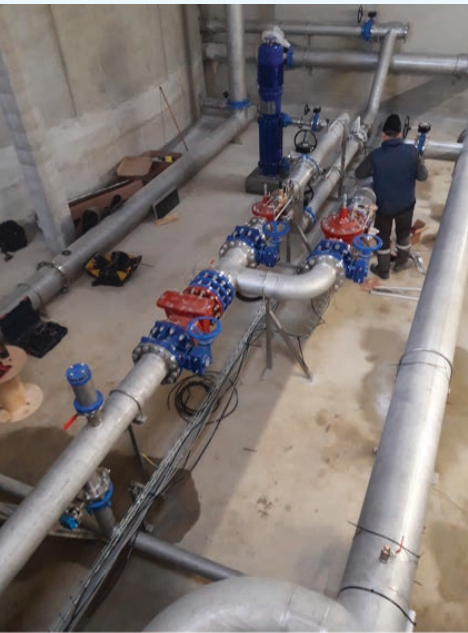
Chambre des vannes du réservoir de Baziège avec la microturbine
