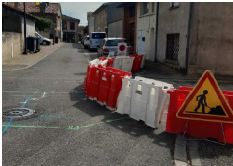
Signalisation route Barrée côté Rue Laurette
