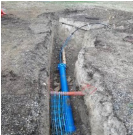
Préparation raccordement château d'eau
