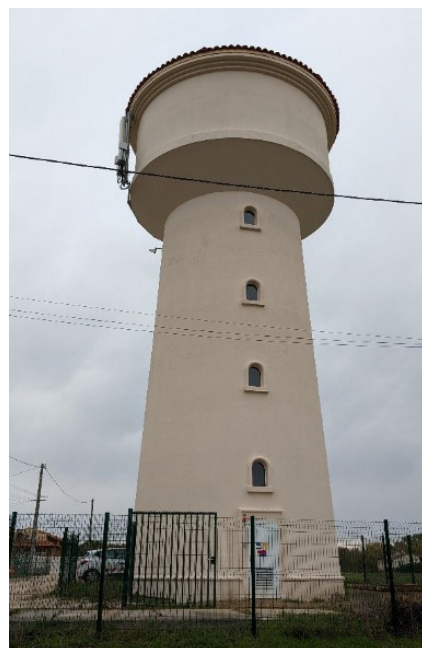
| Réservoir de Villaudric avant / après
