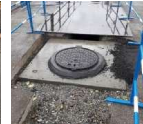
Regard combi III et grave bitume déjà réalisée
