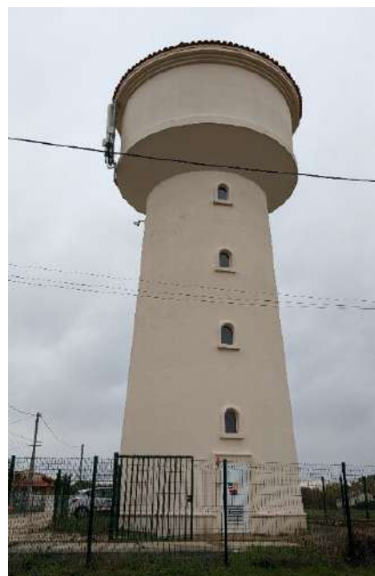
| Réservoir de Villaudric avant / après
