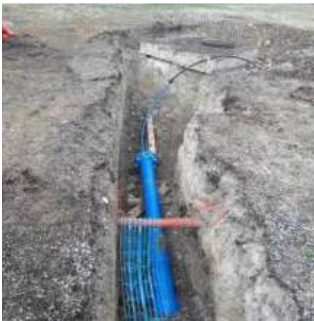
Préparation raccordement château d'eau
