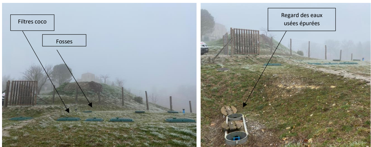
Figure 14. STEP de Juzes (filtres coco) - photos prises par le commissaire enquêteur le 13/01/2022
