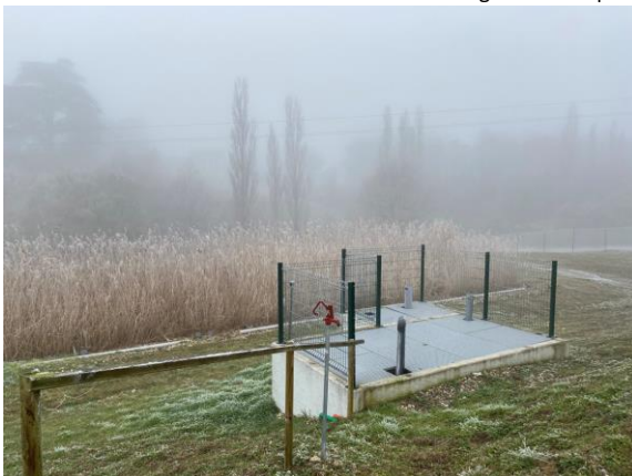
2 ème étage de filtres plantés de roseaux
