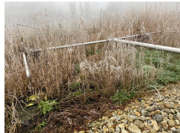
1 er étage de filtres plantés de roseaux
