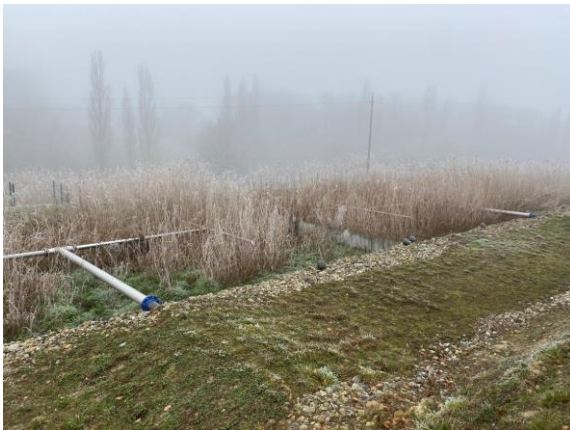
1 er étage de filtres plantés de roseaux
