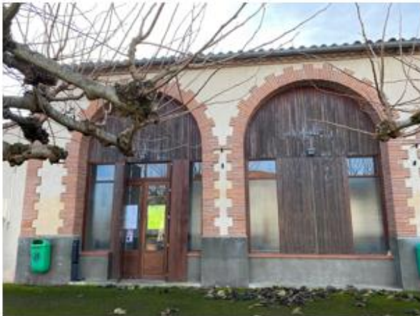
Foyer rural en face de la Mairie
