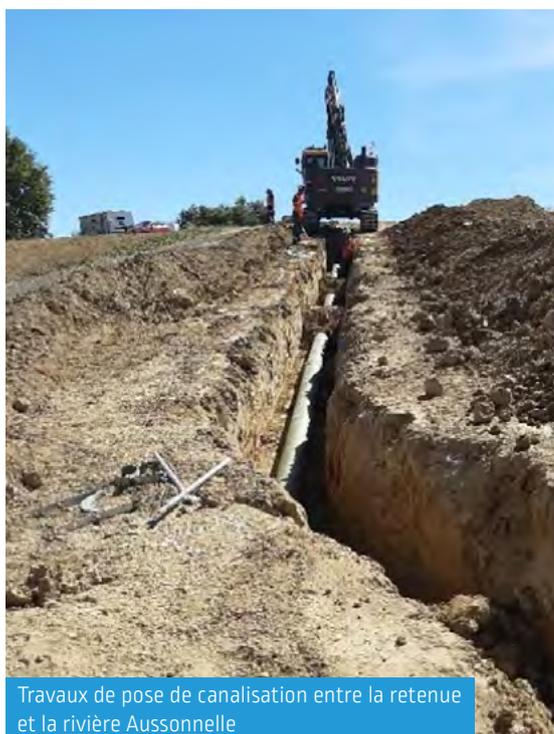
Travaux de pose de canalisation entre la retenue et la rivière Aussonnelle
